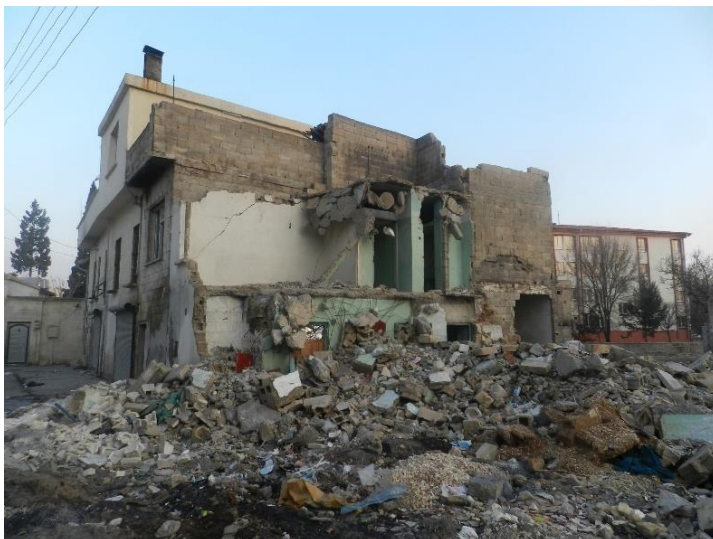
Osittain puretussa rakennuksessa asui useita syyrialaisperheitä.
